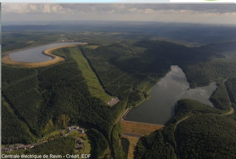
Centrale électrique de Revin - Crédit EDF
