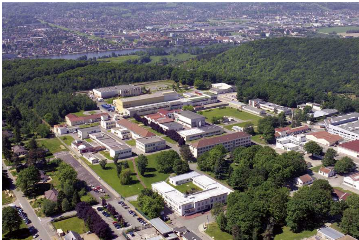
Fig. 1 Vue aérienne du LRBA
