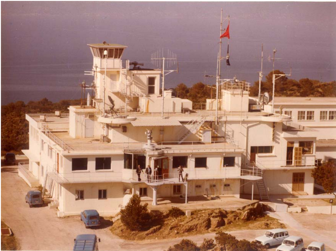
Fig. 3 Poste central de conduite de tir
