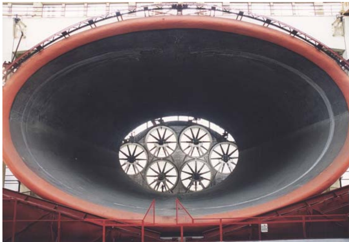
Entrée du diffuseur 16 m x 8 m
