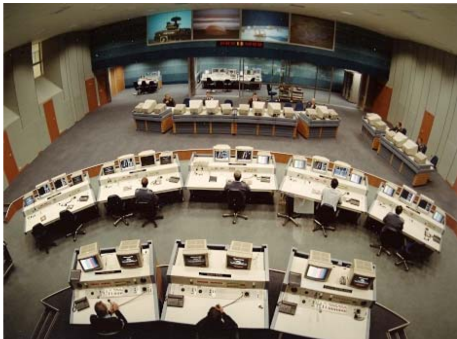
Fig. 10 "Salle OPS" : PCCT (Poste central de conduite de tir)
