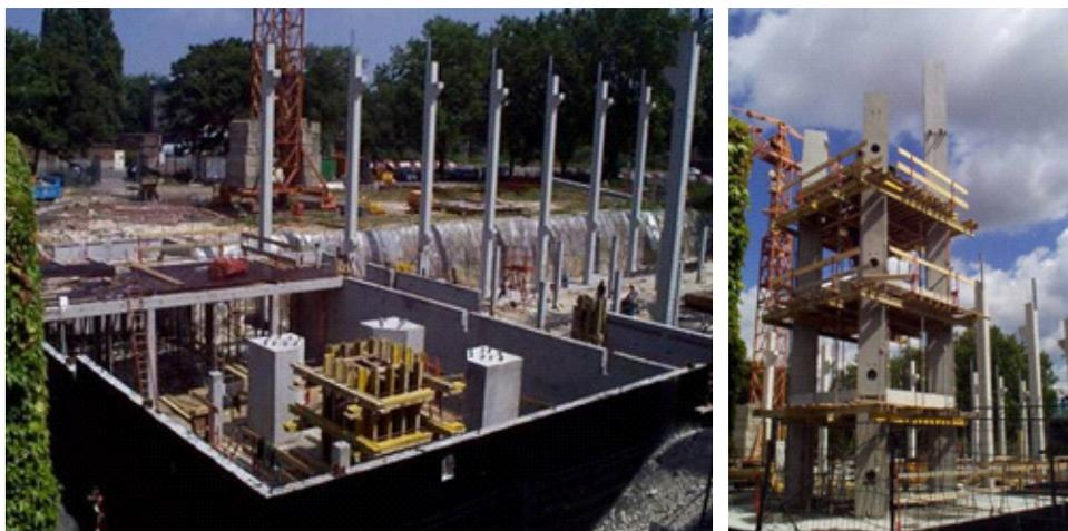
Figure 1. Construction de l'installation avec à gauche les fondations pour l'installation de la masse sismique et à droite l'ossature qui accueillera les 4 colonnes de la Tour.
