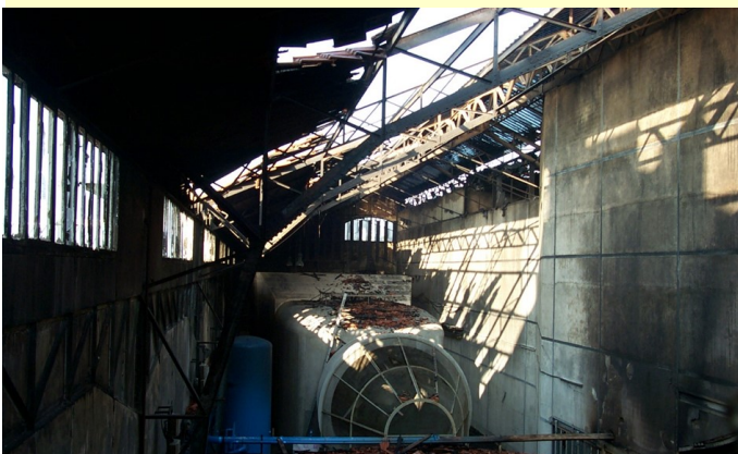
Photo 4 - Grand hall côté sud, vers la soufflerie S2.
