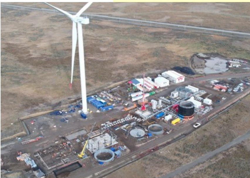
Usine SAF en chantier avec extraction CO 2 de l'air (été 2022) : Haru Oni (Chili).
