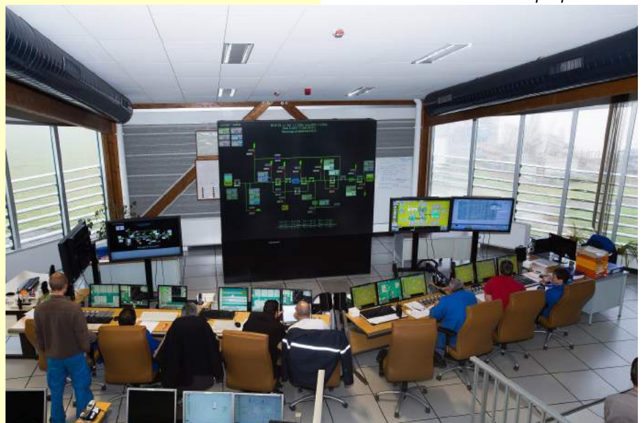
Fig. 2 - Salle de commande TRIPODE, © DGA Essais propulseurs.
